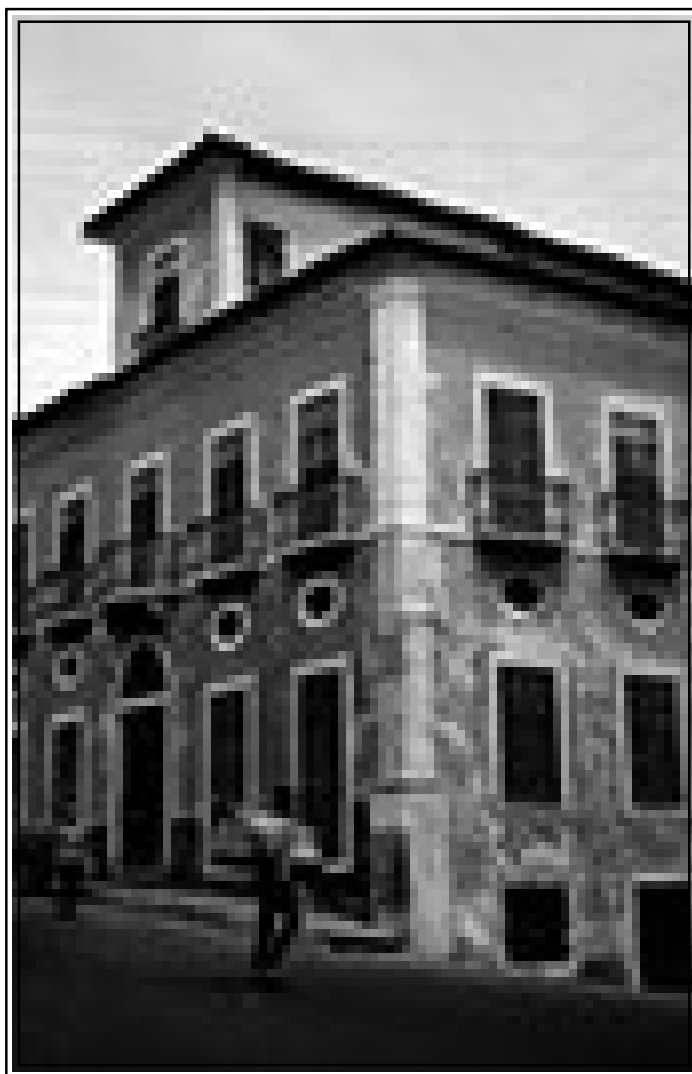
Figura 10. Fotografia do Solar Cesário Veras
